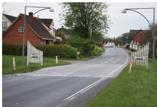
Indkørslen til Båring fra øst på Middelfartvej.
